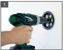
Auf die innere Kreisfläche der PE Montagerondelle 3842 den DoPurCol PU-Kleber 3853 auftragen: Verbrauch: ca. 9–12 ml/Stück (bei z. B. leichten Schildern, Temperaturfühlern und Hausnummern immer erforderlich. Wenn das PE Montagerondell nur durch Querkraft beansprucht wird, ist die Verklebung nicht erforderlich).
