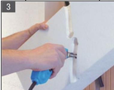
Die Dämmplatte verkleben und dabei gleichzeitig die Elektroleitung oder Kabelschutzrohre durch die Aussparungen führen.
