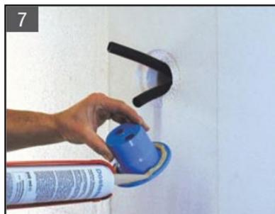
Elektrokabel oder Kabelschutzrohre durch die Durchführungen ziehen und den Elektrodoseneinsatz 3854 dämmplattenbündig in die Ausfräsung fest eindrücken.
