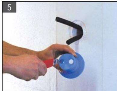
Zu groß geschnittene Aussparungen auf der Dämmplatteninnenseite durch die gefräste Öffnung hindurch mit PUR-Füllschaum 3555 verschließen.
