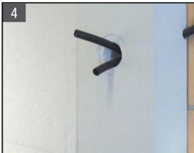
**Montage** Durchführungen für die Zuleitung im Elektrodoseneinsatz 3854 ausschneiden.
