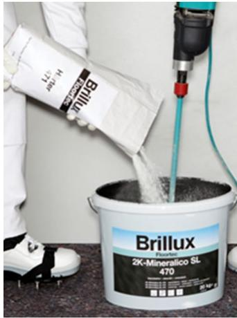
Floortec 2K-Mineralico SL 470 mit Härter 471 anmischen. Rührgerät mit mind. 1300 Watt Leistung einsetzen. Collomix Mörtelrührer DLX 152 HF verwenden oder alternativ ein Doppel-Rührwerk einsetzen.
