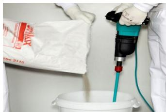
Fußboden-Nivelliermasse 3115 oder Fußboden-Nivelliermasse FX 3109 knollenfrei mit geeignetem Rührwerk und Rührstab ansetzen. Vorzugsweise den Collomix Mörtelrührer DLX 152 HF 3347 verwenden.
