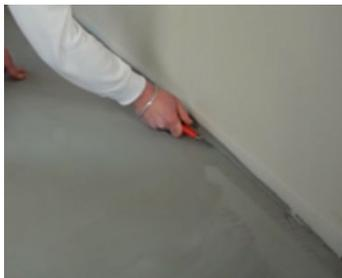
Randdämmstreifen oberflächenbündig mit Cupschnittmesser durchschneiden und entfernen.
