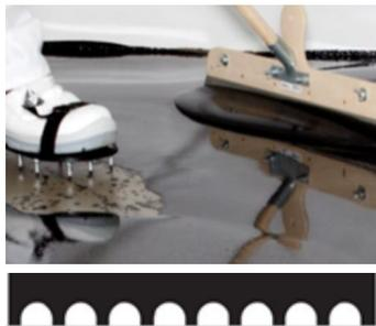
Floortec 2K-Mineralico SL 470 im Rakelverfahren verteilen. Flächen stets vollständig abrakeln und Materialanhäufungen vermeiden.
