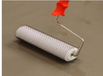
Die frische Nivellierschicht mit der Entlüftungswalze im Kreuzgang durcharbeiten
