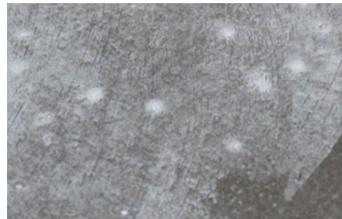
Vorhandene Poren mit Fassaden-Glättspachtel F 1539 verschließen.
