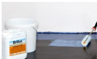
Grundierung je nach Untergrund mit Multigrund LF 3084 (1:3 wasserverdünnt) oder Spezial-Grund LF 3085. Neue Estriche können eine erhöhte Saugfähigkeit aufweisen, sodass ggf. 2x grundiert werden sollte, um eine evtl. Porenbildung in der nachfolgenden Nivellierspachtelung weitestgehend zu vermeiden.
