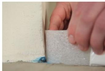
Vorbereitete Bodenflächen absaugen und reinigen. Randdämmstreifen SK 3018 anbringen. Die Verträglichkeit mit und Haftung auf dem Untergrund, insbesondere bei fertig gestellten Oberflächen, ist durch eine Probeverklebung im Vorfeld zu prüfen.
