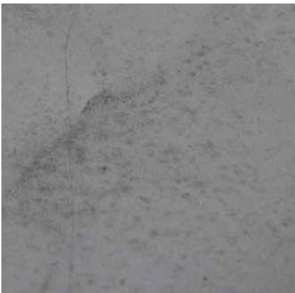
Schwundrisse und kleine Poren durch die Estrichkonstruktion
