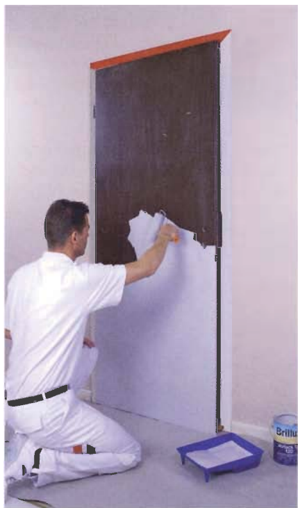
Voranstrich: Die vorbehandelte Altbeschichtung wird mit einem Basecode-Farbton vorgestrichen.
