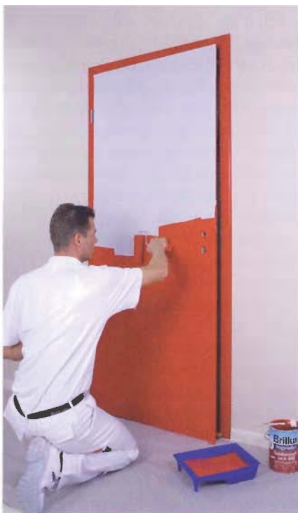
Der Zwischenanstrich erfolgt im kräftigen Farbton der Schlussbeschichtung
