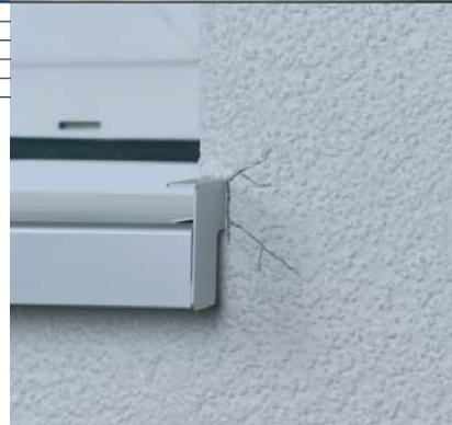
Die positive Wirkungsweise von Wärmedämm-Verbundsystemen ist vom Zusammenspiel zahlreicher Einzelkomponenten abhängig. Eine wichtige Komponente ist die Fensterbank. Diese muss nicht nur optischen Ansprüchen genügen, sondern auch dauerhaft die Schlagregendichtigkeit und den Ausgleich thermisch bedingter Längenänderungen gewährleisten.
