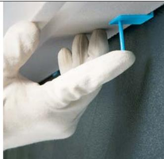
Nach Klebeauftrag Anstellen der Qju Dämmplatten, fluchtgerechte Ausrichtung und unterseitige Fixierung mit Fixierungsnägeln.
