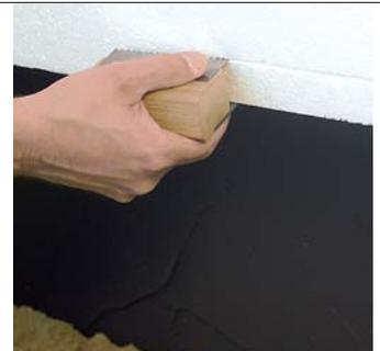
Einschlitzten der unteren Dämmplattenreihe mit dem speziellen Nutfräser 3815.0001, Frässtaub entfernen.
