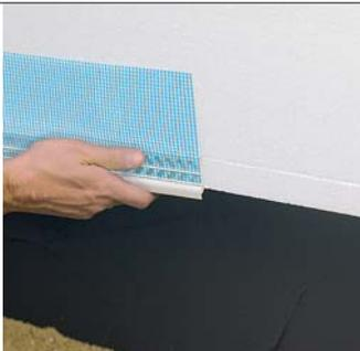
Aufstecken des WDVS Sockelabschlussprofils 3815 inkl. Eck- und Steckverbinder.
