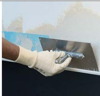
Gewebefahne einarmieren und anschließende Flächenarmierung.
