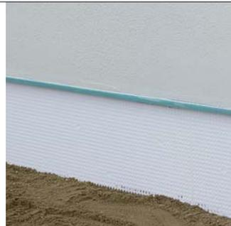
Verklebung der Sockeldämmplatten inkl. WDVS Dichtband.
