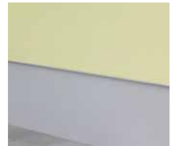
... Fläche armieren, Oberputz auftragen, Sockeldämmung ausführen und fertig.
