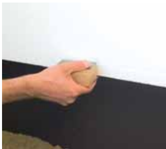
Einfach die untere Dämmplattenreihe mit dem speziellen Nutfräser einschlitzen, ...
