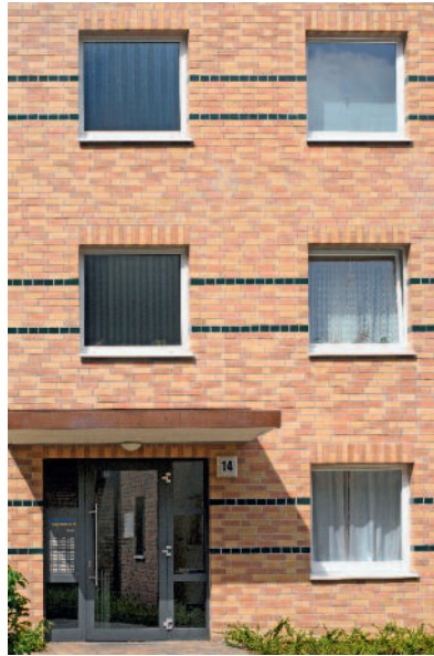
5 – 7 Brauþpark 14, Hamburg: Das zuvor unscheinbare Gebäude erhielt durch die feine Abstimmung von keramischen Belägen, Bänderungen, Putzen und Farbigkeiten eine edle Mischfassade.
