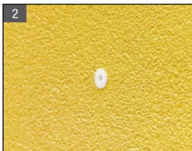
Die anschließende Befestigung der Bauteile erfolgt mit Blech-/ Holzschrauben Ø 4–5 mm. Die Länge der Schrauben ergibt sich aus der Befestigungsdicke der Bauteile + 30 mm Verankerung im Montagedübel.
