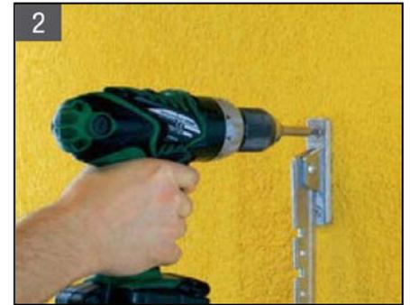
Bauteil im EPS Montagezylinder verschrauben.
