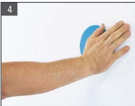
Den Zylinder dämmplattenbündig in die Aussparung einsetzen und anpressen.
