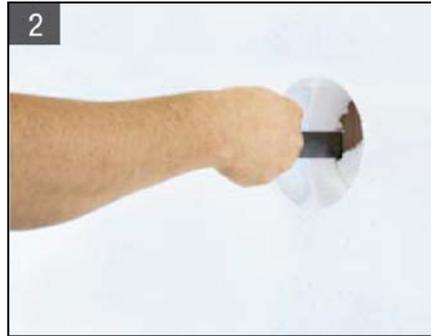
Die Restdicke mit geeignetem Werkzeug herauskratzen und Ausfräsung vom Frässtaub reinigen.
