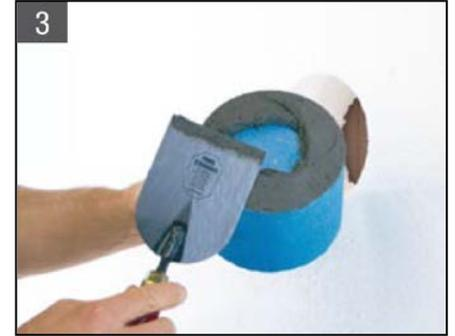
Auf die Rückseite des Montagezylinders den jeweils zur Verklebung der Dämmplatten eingesetzten Kleber (WDVS Pulverkleber 3550 oder WDVS Klebe- und Armierungsmörtel L 3500) auftragen. Der Montagequader muss vollflächig verklebt werden.
