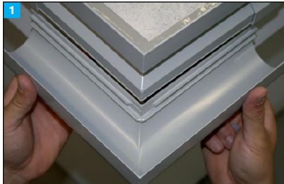
Die BR Balkonrinne bzw. BR Rinnenecke von hinten in das befestigte BP Beschichtungsprofil einhängen
