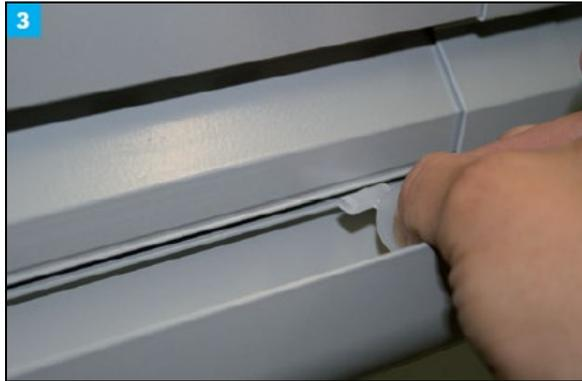
Im Stoßbereich zweier Rinnenelemente zunächst Fugen lassen (bei Einbautemperaturen bis +10 °C ca. 8 mm, bei höheren Einbautemperaturen ca. 5 mm)
