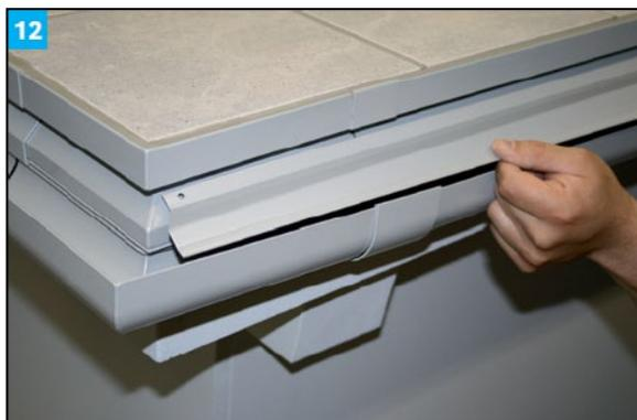
Abschließend erfolgt der Anschluss an ein bestehendes Fallrohr.
