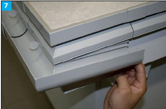
Für die Balkonseite mit dem Anschluss der Balkonrinne an das Fallrohr, das BR Rinnenablaufelement mit der Rinne vormontieren.
