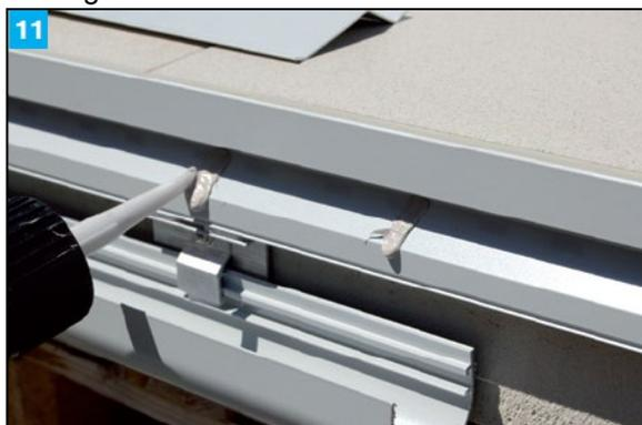
Die GB Gefälleblende (links oder rechts) an dem Beschichtungsprofil ansetzen und fest andrücken.
