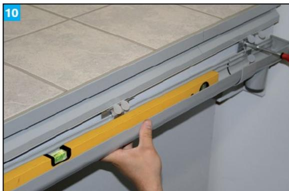
Siliconstreifen in Abstand von 10–15 mm an dem Beschichtungsprofil auftragen.
