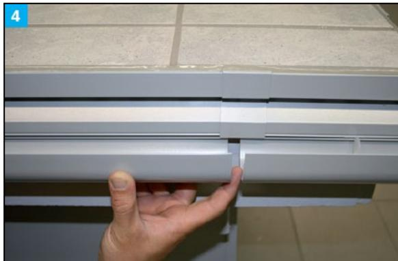
Den Fugenbereich mit dem BR Rinnenverbinder abdecken. Den Rinnenverbinder zuerst hinten einhängen, dann vorne arretieren. Hierzu mit der einen Hand die Rinne nach unten und mit der anderen den Verbinder nach oben drücken bis er einrastet. Ebenso werden die Ablaufelemente ins Rinnensystem eingebunden.
