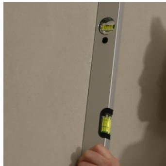
Untergrund durch Augenschein, Ritzprüfung, Feuchtemessung, Haftzugprüfung etc. auf Tragfähigkeit und Ebenheit prüfen.
