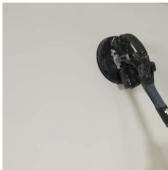
Eventuelle vorhandene Grate und Kleberüberstände nach Trocknung von Hand oder auch maschinell entfernen.
