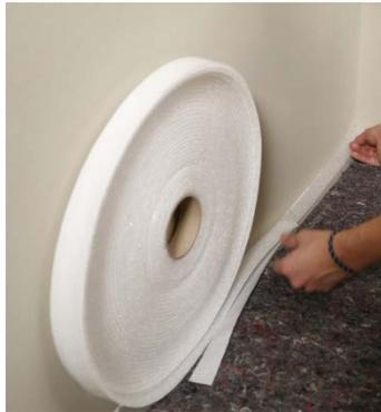
Den KlimAir Entkopplungsstreifen 1867 umlaufend an Boden, Decke und angrenzenden Wänden sowie an allen beweglichen Bauteilen, z. B. Fenstern und Türen, anbringen.
