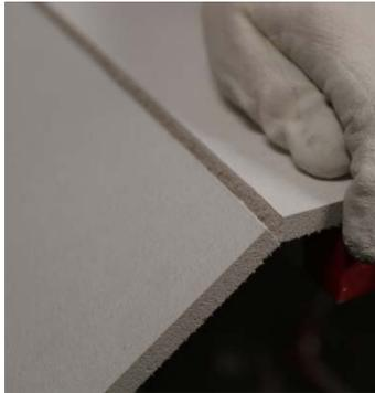
Die Platte über eine Kante brechen und abtrennen oder alternativ mit einer Säge zuschneiden.
