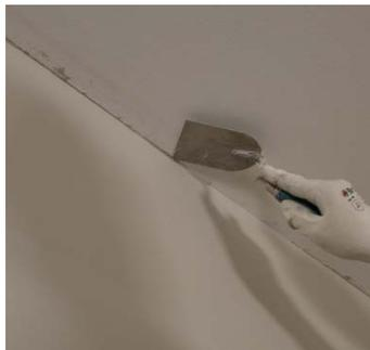
Trennschnitt (Kellenschnitt) an den Anschlussbereichen entlang der verlegten KlimAir Entkopplungsstreifen 1867.
