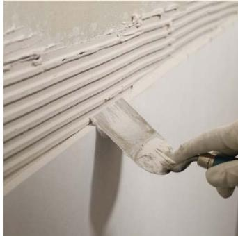
Die Randbereiche für die Kontaktverklebung mit dem Kleber benetzen.
