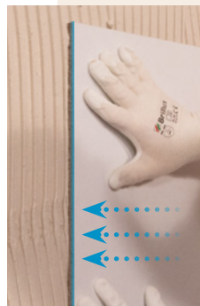
Kondensat aus der Raumluft wird gepuffert
